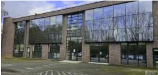
L'immeuble de Trappes était soumis à un risque d'inconfort thermique pour les locataires du fait de sa verrière. En cas de vague de chaleur, les vitrages laissaient passer les rayons infrarouges du soleil, ce qui réchauffait l'intérieur du bâtiment. Les locataires étaient alors obligés de climatiser l'immeuble.
