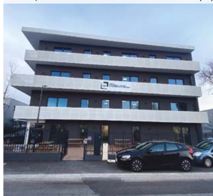
La Canopée – 390 rue C. N. Ledoux – Aix-en-Provence (13)
