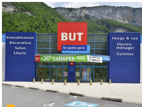
Zone Industrielle de la Maladière à Cluses (74)
