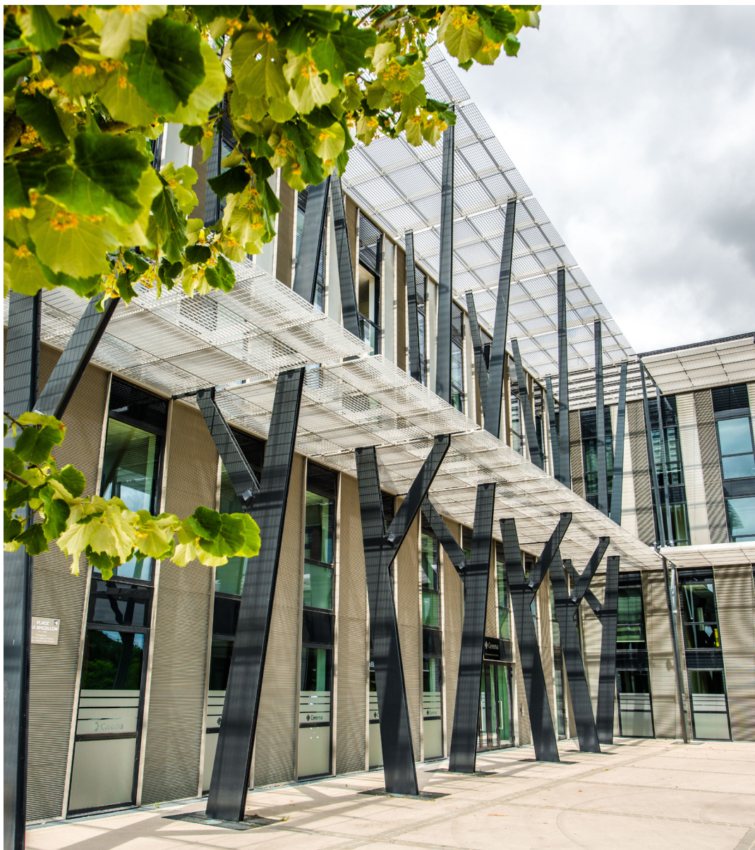
Rue de Beauvais - Margny-lès-Compiègne
