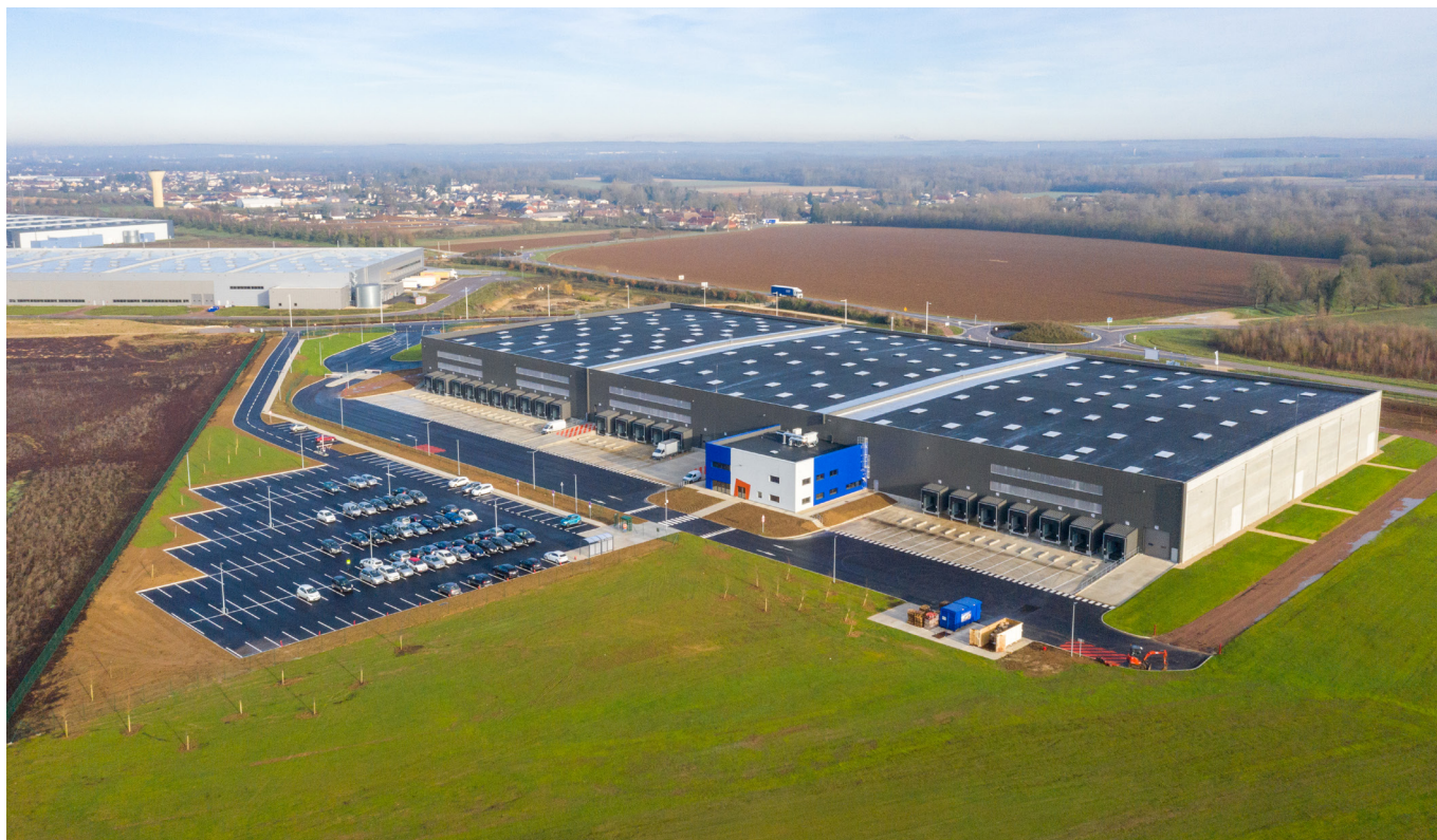
Zac du Parc Logistique de l'Aube - Troyes
